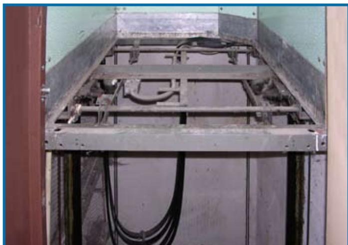
Obrázek č.3: Stav po demontáži, vyřazení nášlapu z provozu.
