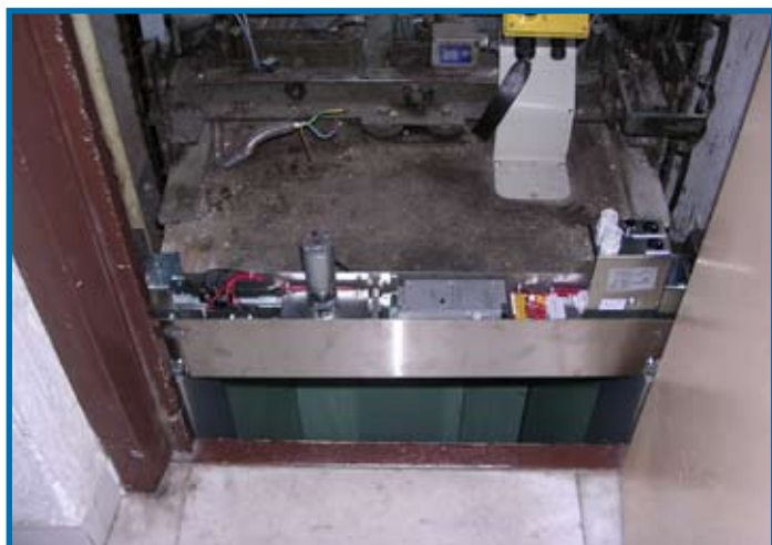
Obrázek č.7: Horní pohled na namontovaný pohon (bez krytu).
