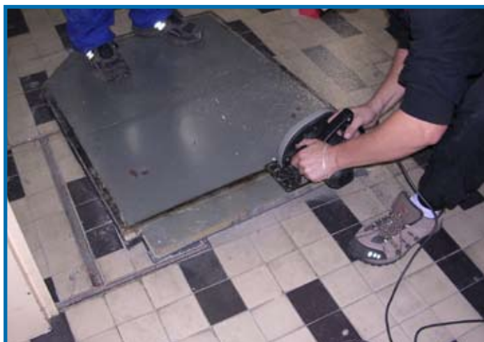
Obrázek č.4: Úprava délky podlahy.
