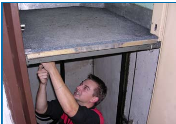
Obrázek č.2: Demontáž dřevěné podlahy.
