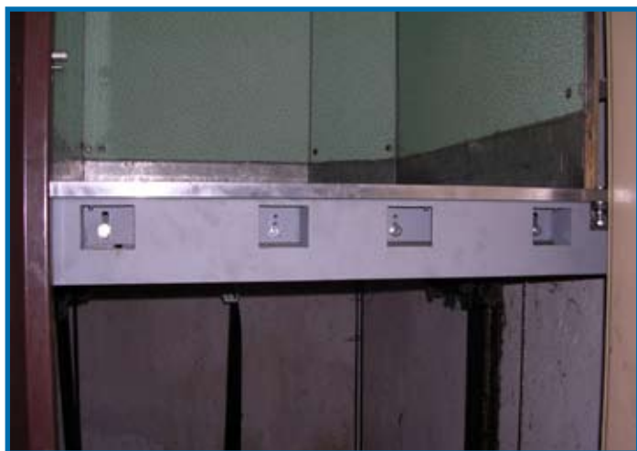
Obrázek č.5: Namontovaný práh.
