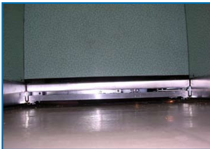
Obrázek č.6: Spodní pohled na namontovaný pohon (bez krytu).
